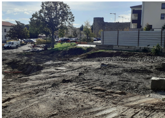
Préparation du terrain
