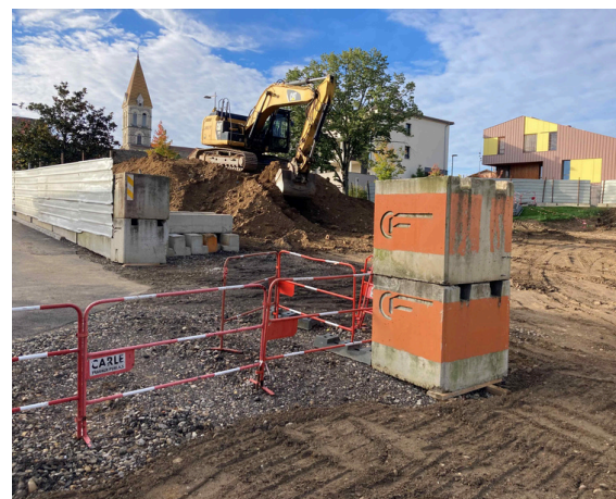
Début du terrassement
