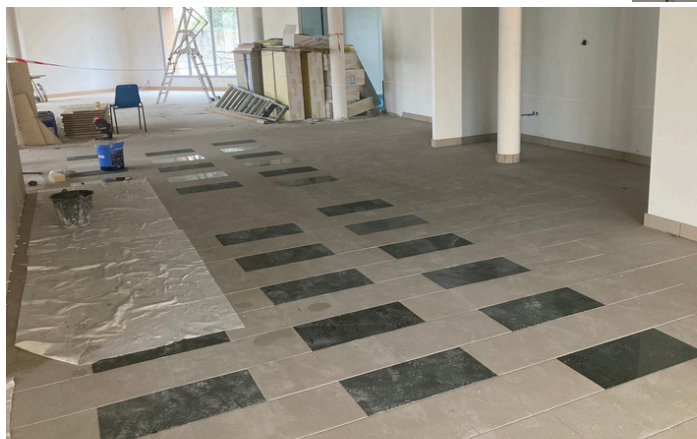
Pose des carrelages
