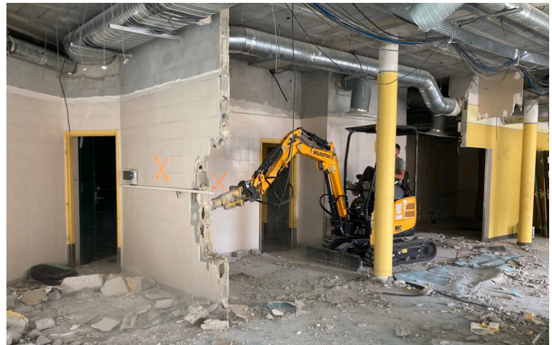
Démolition des cloisons dans le restaurant scolaire
