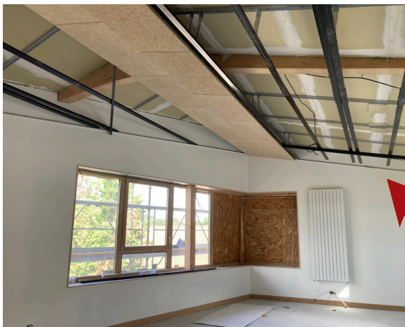
Pose des faux-plafonds
