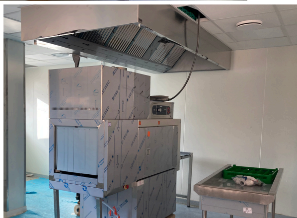
Pose des équipements de cuisine
