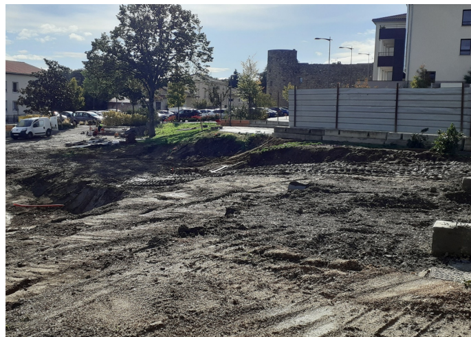
Préparation du terrain
