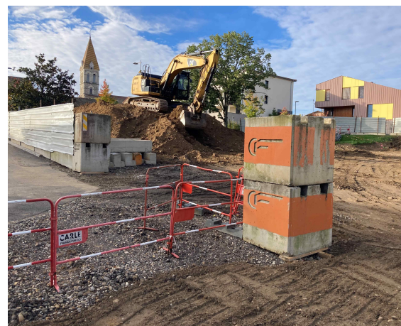
Début du terrassement
