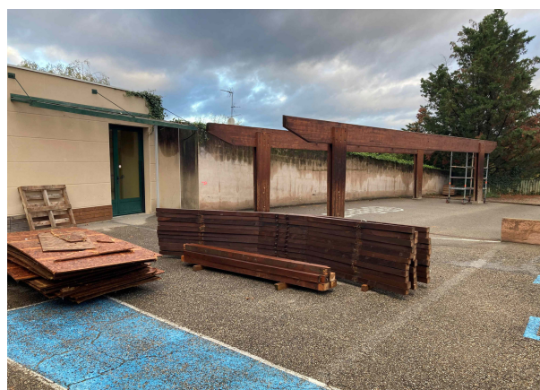
Démontage des préaux
