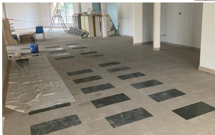
Pose des carrelages
