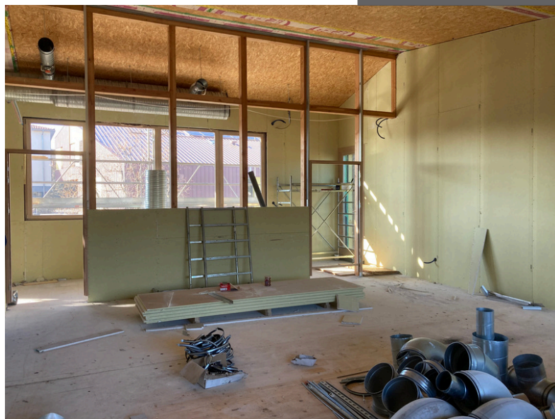
Pose des cloisons des salles de classe ▲
