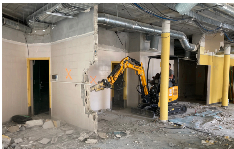
Démolition des cloisons dans le restaurant scolaire
