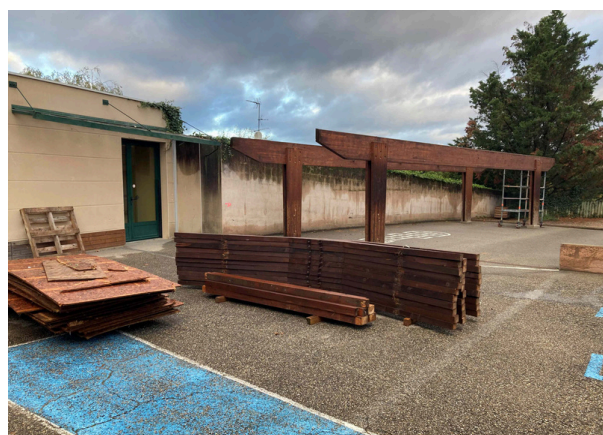
Démontage des préaux
