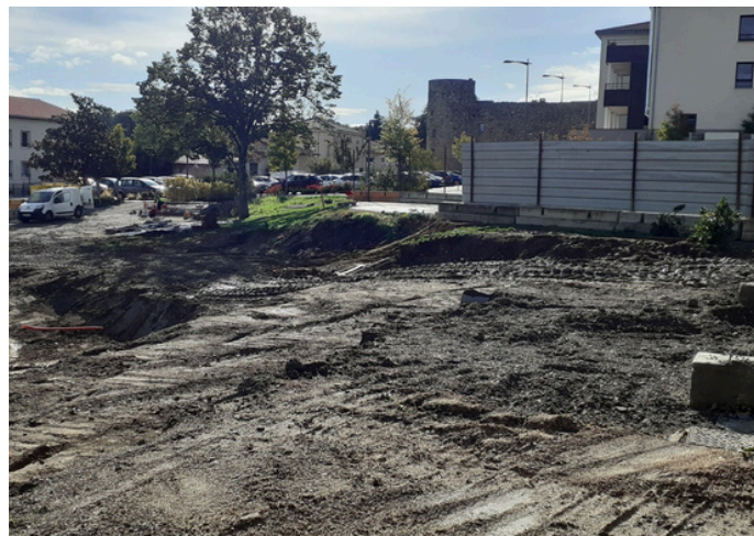
Préparation du terrain
