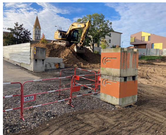
Début du terrassement
