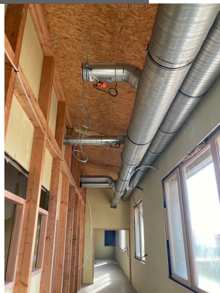
▲ Installation du traitement d'air
