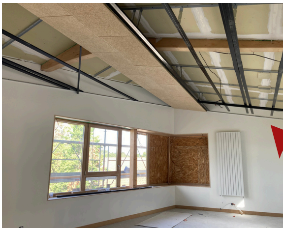
Pose des faux-plafonds
