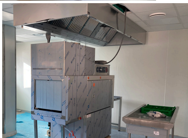
Pose des équipements de cuisine
