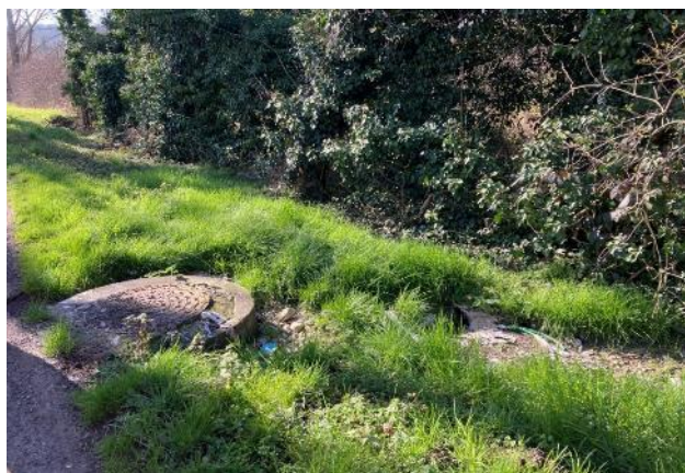
Point de débordement – chemin de la Tuilerie
