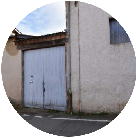
Porte existante en bois
