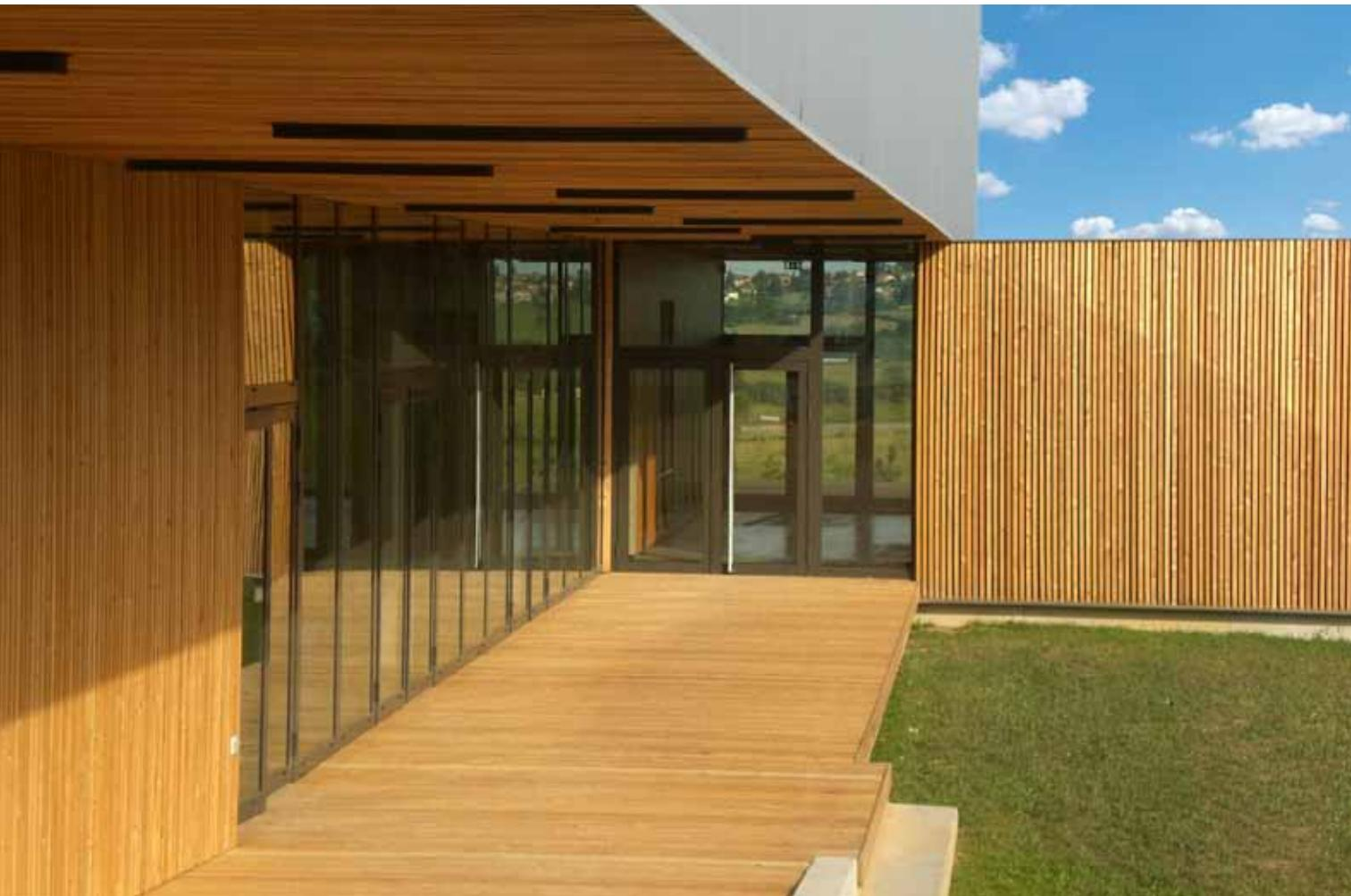
**L'Héliotrope** est un bâtiment à énergie positive, produisant plus d'énergie qu'il n'en consomme. Ses besoins en chauffage sont réduits grâce à une isolation renforcée des parois, une importante étanchéité
