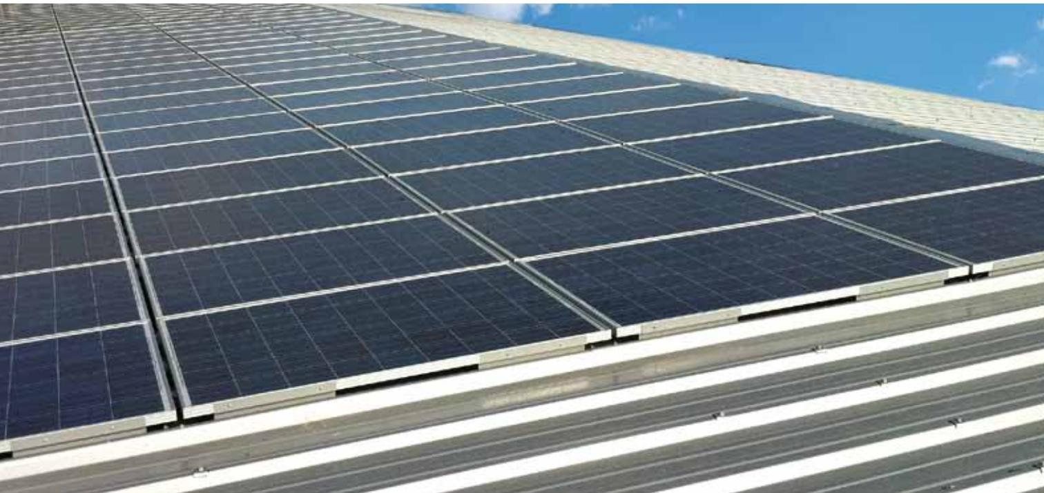
Intégrés dans l'architecture du bâtiment, 204 m<sup>2</sup> de panneaux photovoltaïques compensent, par leur production, l'électricité consommée par **L'Héliotrope**, lui conférant ainsi la qualité de bâtiment à énergie positive. **L'Héliotrope** tient son nom de la plante qui suit la lumière du soleil. Elle symbolise parfaitement ce bâtiment tourné lui aussi vers le soleil, grâce à ses panneaux solaires.
