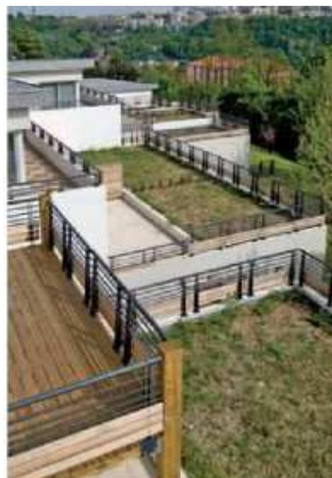
Toiture terrasse végétalisée, pour une meilleure gestion des eaux pluviales et de la thermique des bâtiments.
