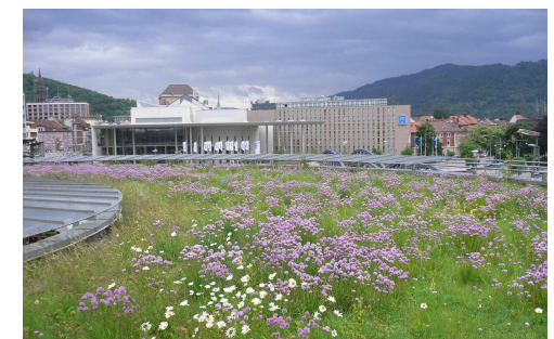
En toiture terrasse...
