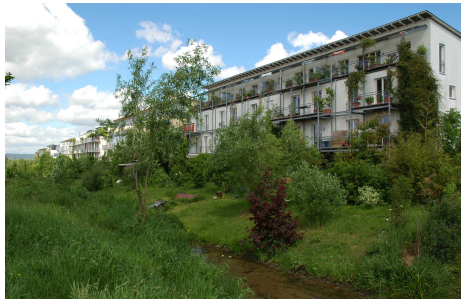
Traitement de l'eau pluviale et aménagement paysager
