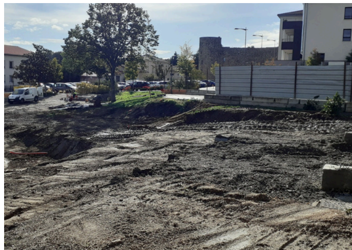
Préparation du terrain
