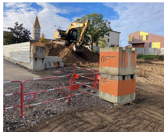
Début du terrassement
